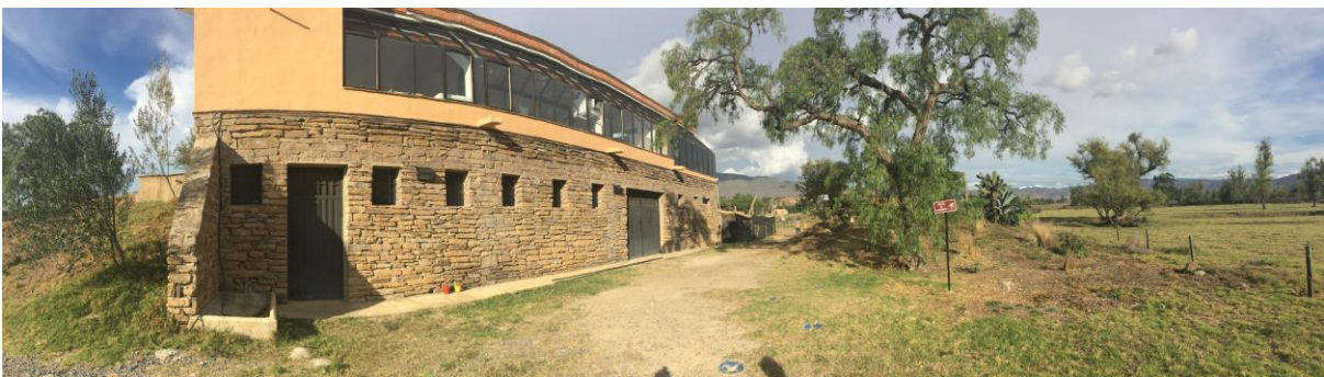
Panorámica vista desde afuera de la entrada a la bodega, la cual está debajo de la sala de exhibición, y áreas de didáctica exteriores
